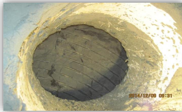
شکل ۱۱. وضعیت سینه کار حفاری قبل از برخورد به زون ریزشی
