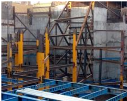
شکل ۱۰. الف) آسیب‌های وارده به ساختمان ۳ طبقه مجاور گود در مقطع C، ب) حفاری در مقطع C بدون نصب مهارهای کافی و افزایش روند صعودی تغییر شکل‌ها، ج) نصب مهارهای اضافی برای جلوگیری از افزایش تغییر شکل‌ها در مقطع C
