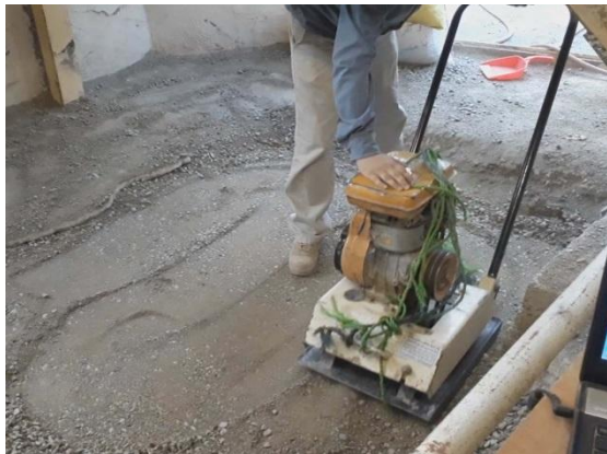
شکل ۴. تصویری از کوبیدن بستر با کمپکتور بنزینی
