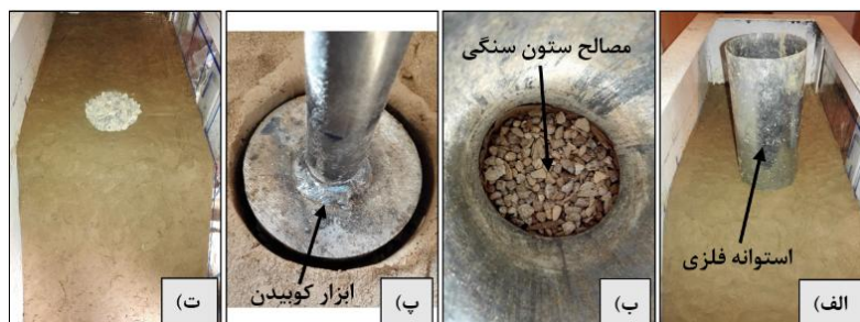
شکل ۶. مراحل اجرای ستون سنگی غیرمسلح: (الف) فرو کردن استوانه فلزی داخل خاک، (ب) ریختن مصالح ستون و کوبیدن مصالح در لایه‌های ۵ سانتی‌متری، (پ) ستون اجرا شده در لایه یکی مانده به آخر و ابزار کوبیدن مصالح ستون، (ت) ستون سنگی تکمیل شده
