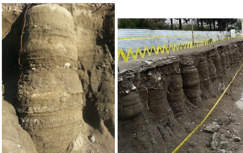
شکل ۶. برداشتن خاک اطراف ستون‌ها به منظور کنترل قطر
