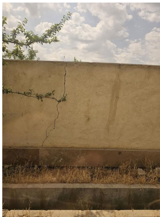
شکل ۳. ترک خوردگی در دیوار بنای جدید ساز و دیوار و پی بنای قدیمی در اثر برداشت آب (دشت هشتگرد)
