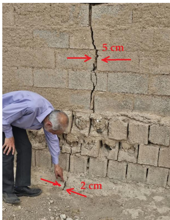
شکل ۳. ترک خوردگی در دیوار بنای جدید ساز و دیوار و پی بنای قدیمی در اثر برداشت آب (دشت هشتگرد)
