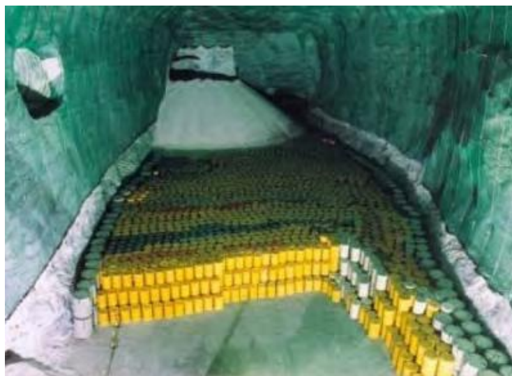
شکل ۱. مرکز دفن ضایعات هسته‌ای در گنبد نمکی
