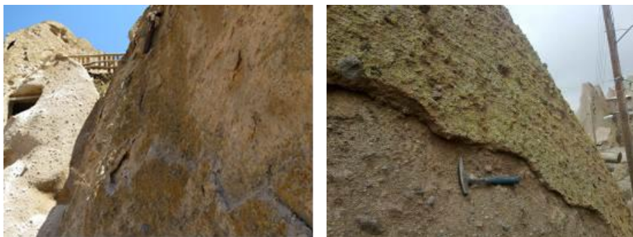
شکل ۱۳. هوازدگی و تخریب سطوح مخروط‌های سنگی کندوان
