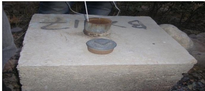
شکل ۳. تصویر کلی یک پیزومتر
